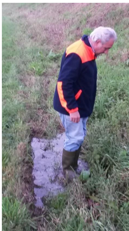
Figura 3-15: Venuta d'acqua al piede del rilevato arginale a lato campagna.
