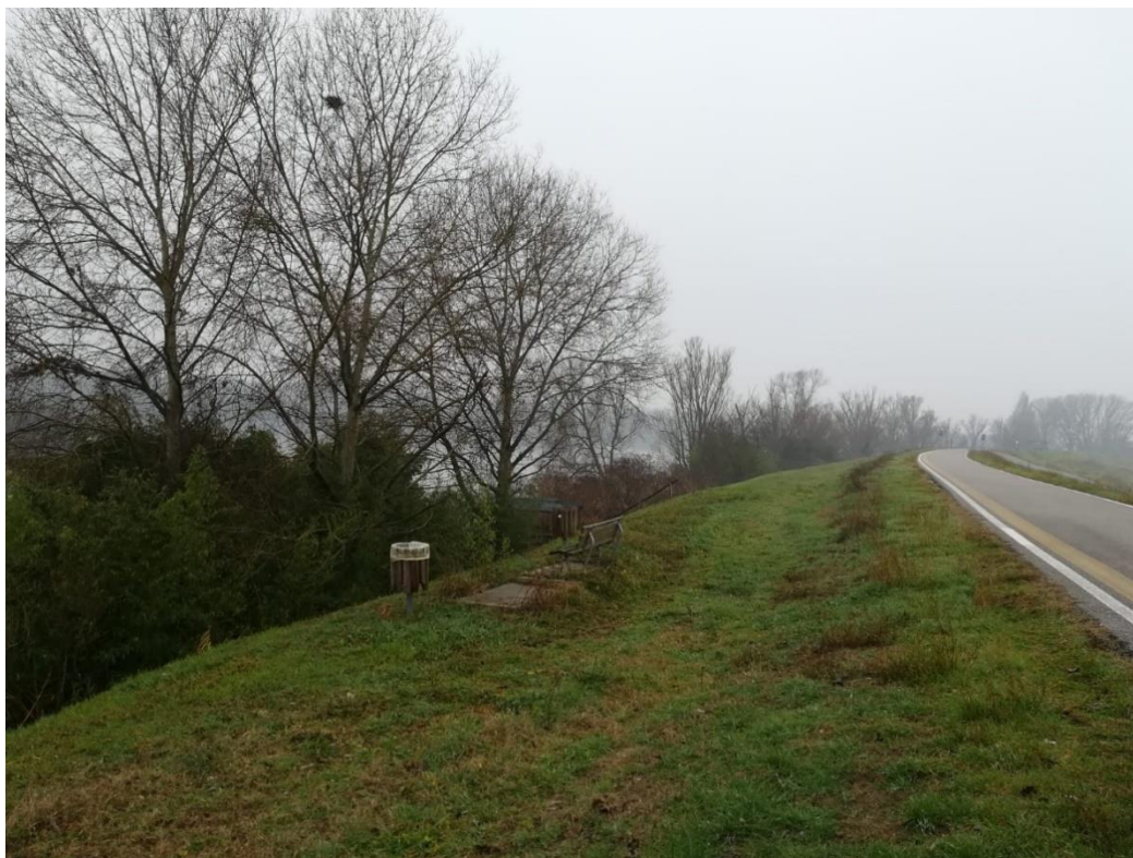
Figura 3-4: Foto 3 – A sinistra è individuabile il lato di argine su cui verrà installato il diaframma, al centro la strada di sommità arginale, a destra lo svincolo per via Roma.
