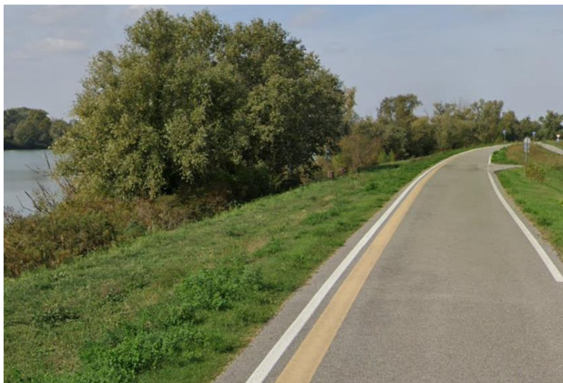
Figura 3-3: Foto 2 – A sinistra è individuabile il lato di argine su cui verrà installato il diaframma, a destra la strada di sommità arginale.
