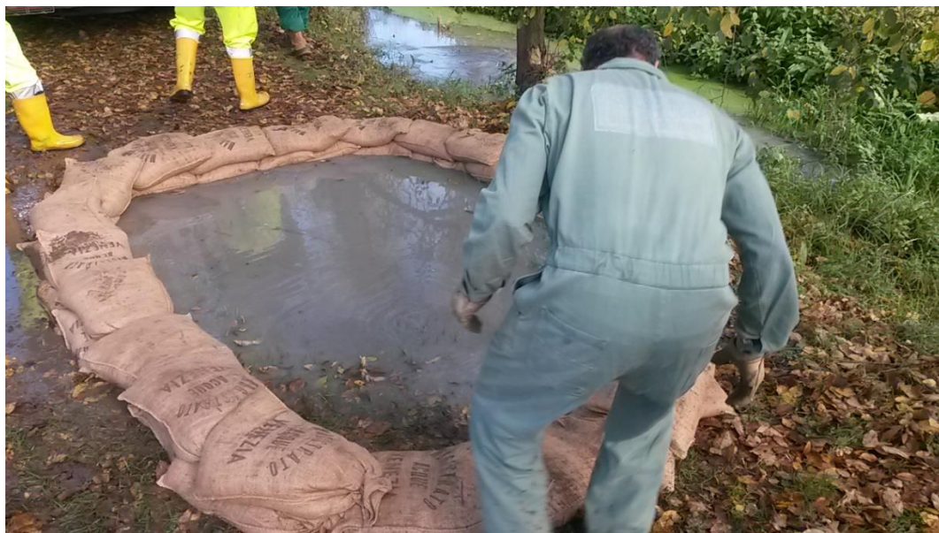
Figura 3-14: Fontanazzo con coronella di sacchetti di sabbia nei pressi dell'abitato di Corbola.
